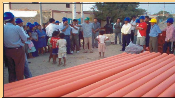
Ampliacion del alcantarillado en el AA.HH. Ritche Prada - Morrope ejecutada en 2 etapas; monto de inversion S/. 30 152.70
