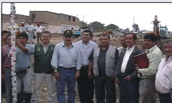
El Ministro de Agricultura Manuel Manrique Ugarte en compañía del Alcalde Percy Ramos y el Congresista Wilmer Rengifo Ruiz supervisando el trabajo que se realiza en la canalización del Canal San Rumualdo.
