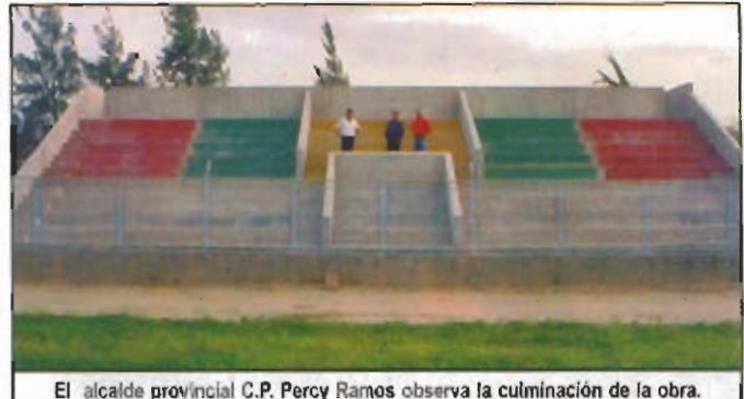
El alcalde provincial C.P. Percy Ramos observa la culminación de la obra.
